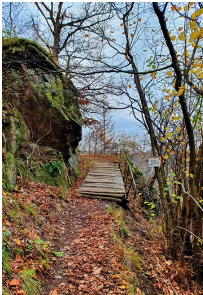
Holzbrücke zum Elverstein
