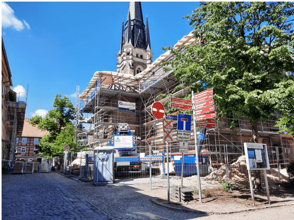
Abbildung 1: Umbauarbeiten an der Wernigeröder Liebfrauenkirche im Jahr 2020.
